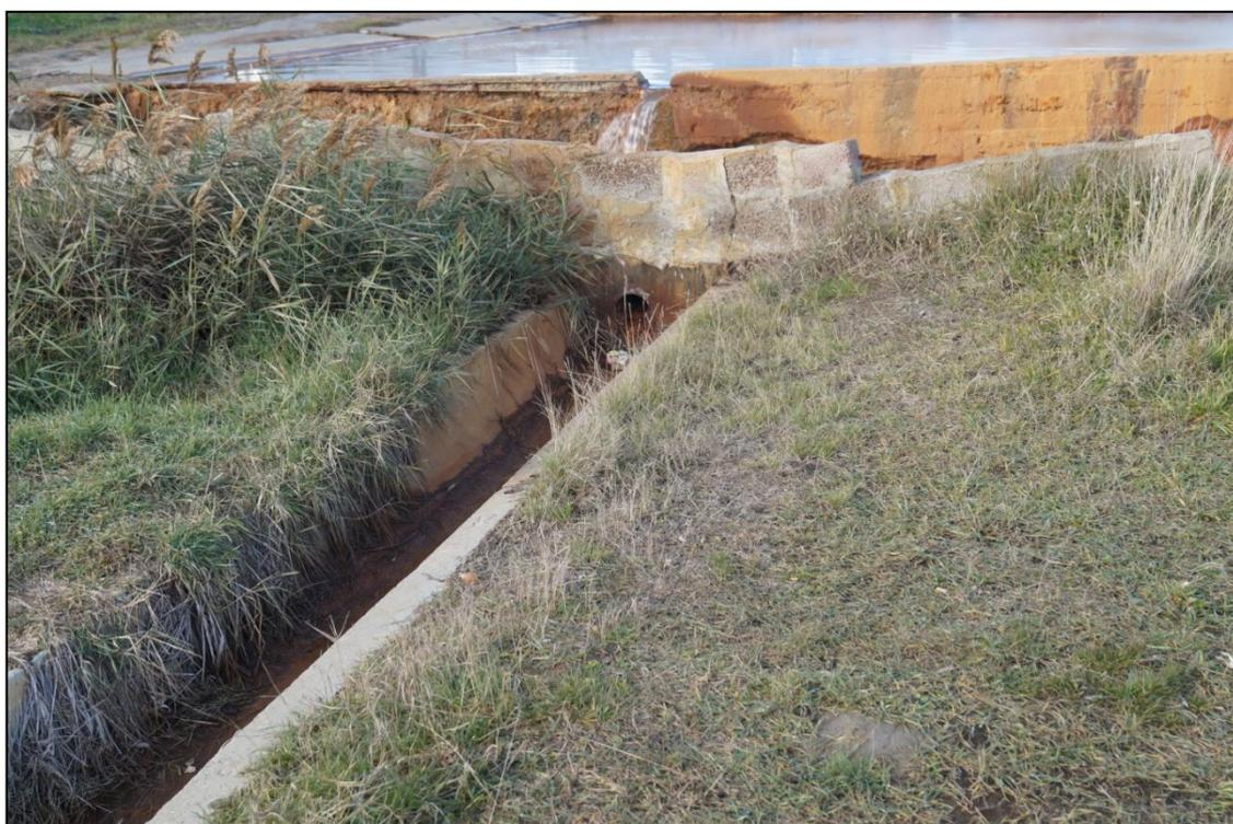
Рисунок 2. Слив минеральной воды в отводящий коллектор
