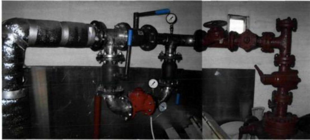
Рис.7. Скважина 3Б, МСЧ «Нефтяник». Устьевое оборудование [21]
