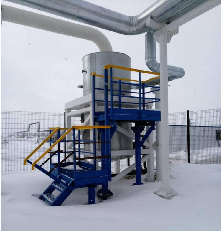
Пусковой расширитель парогенераторной установки в тепловой изоляции с площадками обслуживания.
