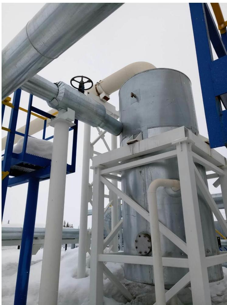
Трубопровод пускового дренажа Т99 (по схеме технологической) в тепловой изоляции.
