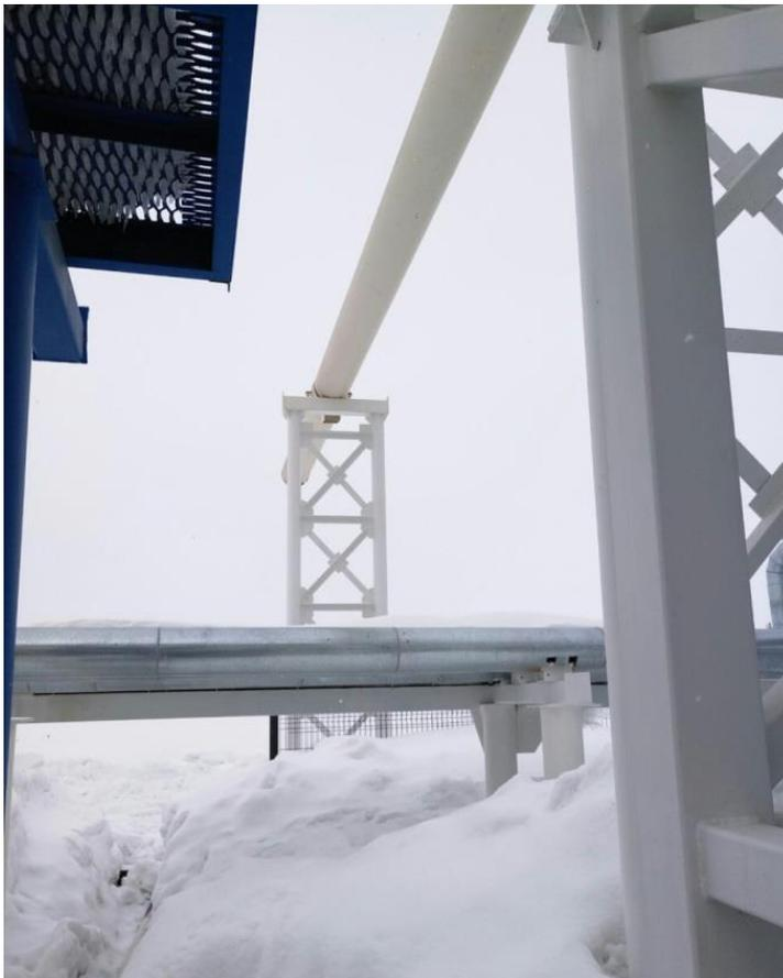
Трубопровод выхода пара в атмосферу Б25 (по технологической схеме) на опорах, без теплоизоляции.
