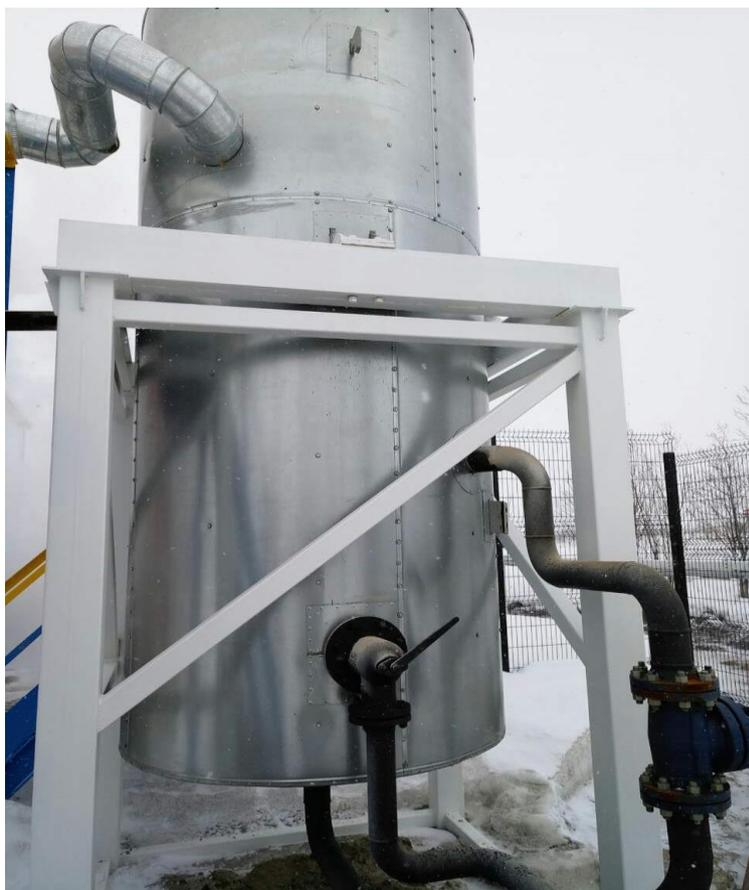
Регулятор уровня и обвязка патрубков для отвода дренажа из пускового расширителя.
