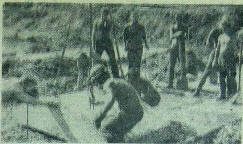
Первая «подушка» из бетона.
