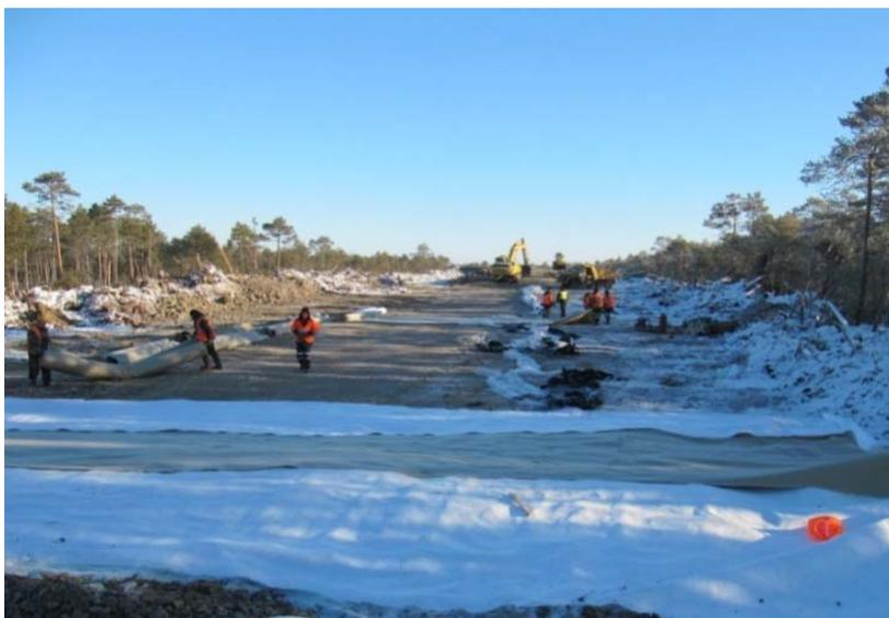
*Рис. 3.* Укладка геосинтетического материала при строительстве экспериментальных участков
