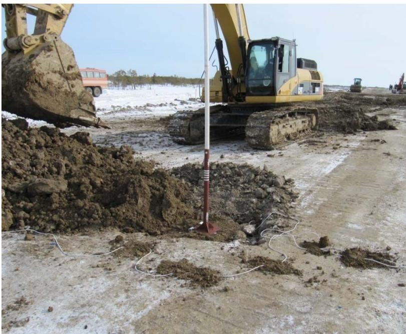
*Рис. 4.* Отсыпка первого слоя с установкой марок для определения осадок основания при строительстве экспериментальных участков
