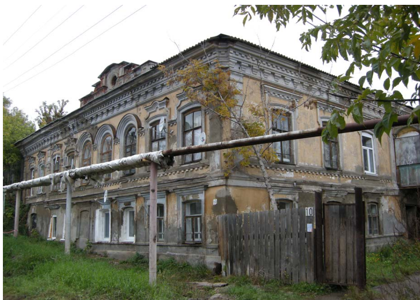
Рис. 2. Дом Дедюхиной. Г. Сарапул, ул. Горького, 10. Фото Н. В. Рыжковой, 2012 г.
