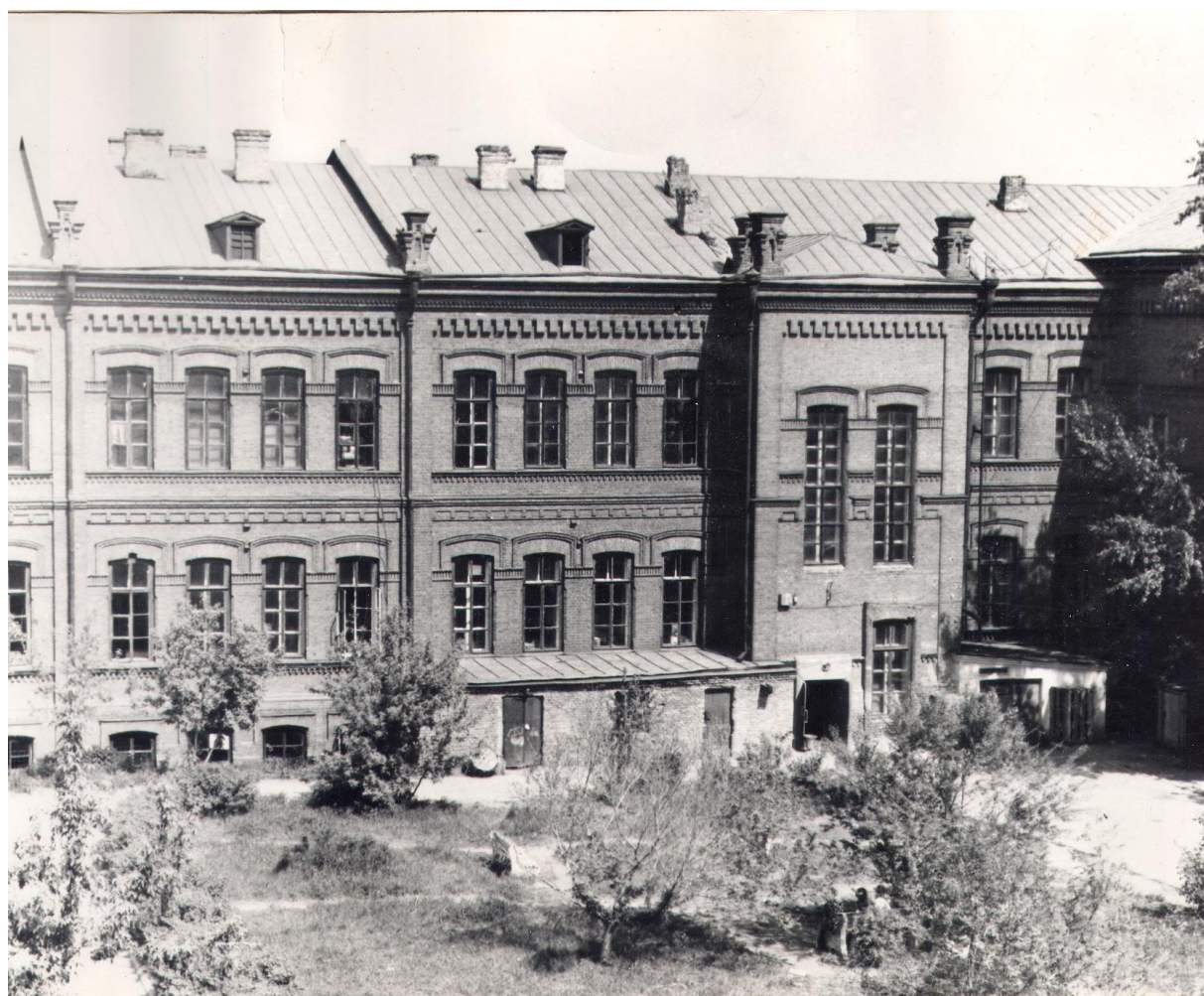
Здание физико-математического факультета. Фото из архива С.Г. Полянской
