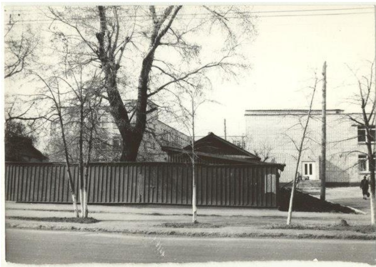
Корпус №5 ТюмГУ в 1980 гг. Кроме математического факультета, в корпусе размещались исторический, юридический и экономический факультеты. Физико-химическое крыло еще не было построено, и вход был со стороны ул. Перекопской. Фото из Музея истории ТюмГУ
