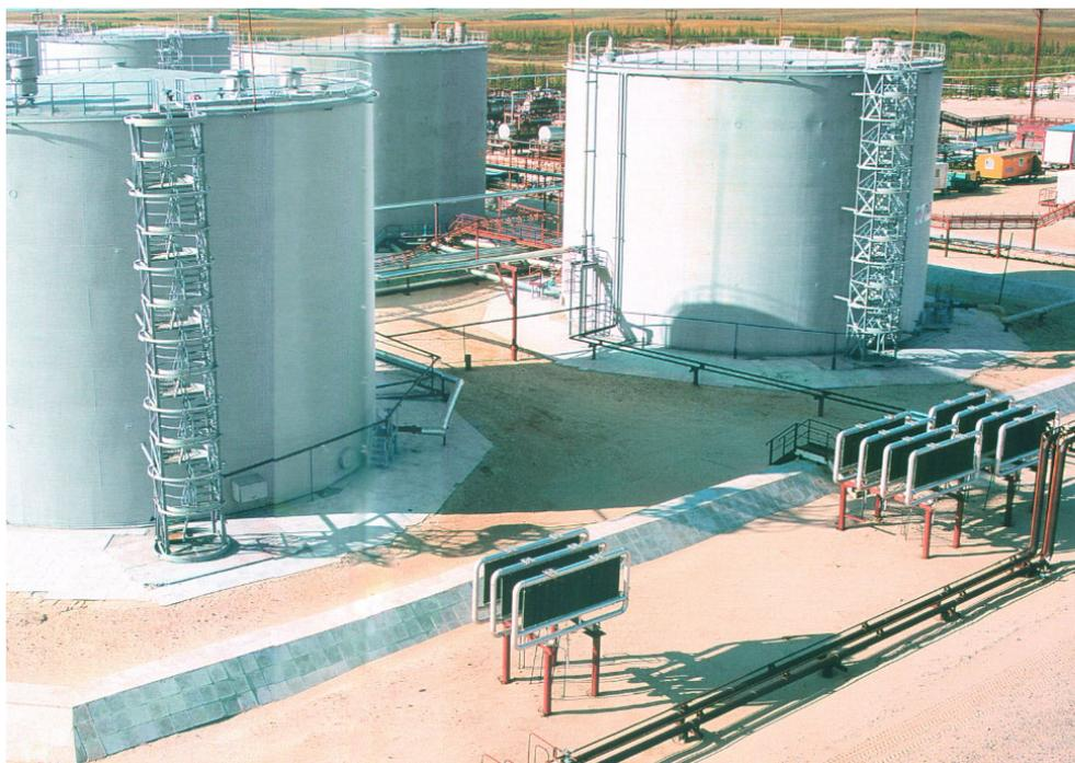
*Рис. 2.* Пример размещения системы ГЕТ в основании резервуара с горячей водонефтяной смесью
