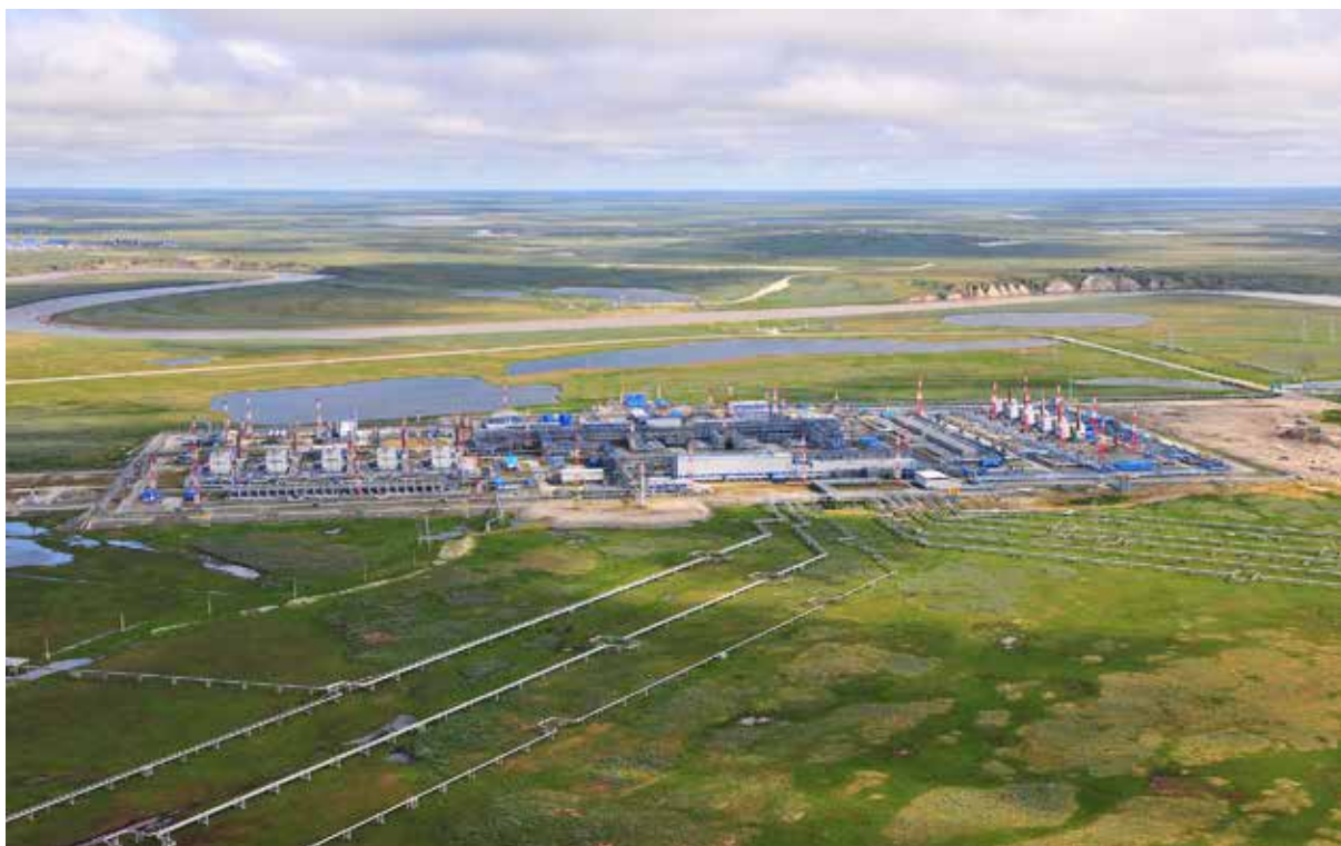
Газовый промысел № 1 Бованенковского месторождения
