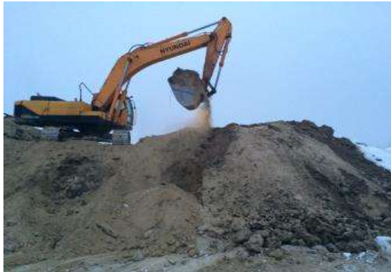
Рис. 1.1. - Сушка бурового шлама ( фото автора )
