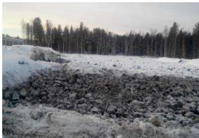
Рис. 2.3.– Внесение цемента и ГКЖ (фото автора)
