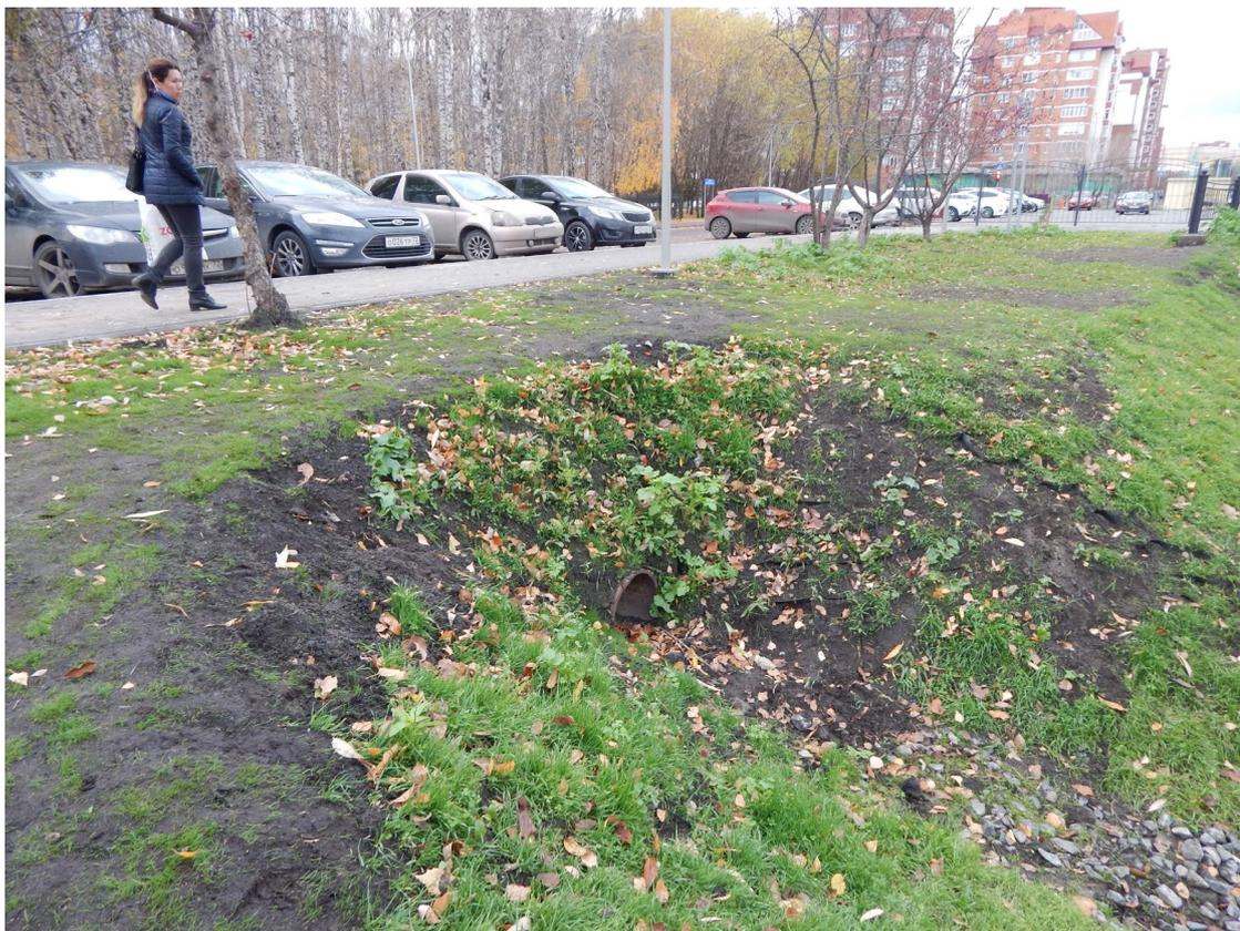
Рисунок 4. Железная труба для слива дождевых и талых вод в обводненный карьер Школьный [фотография сделана автором]
