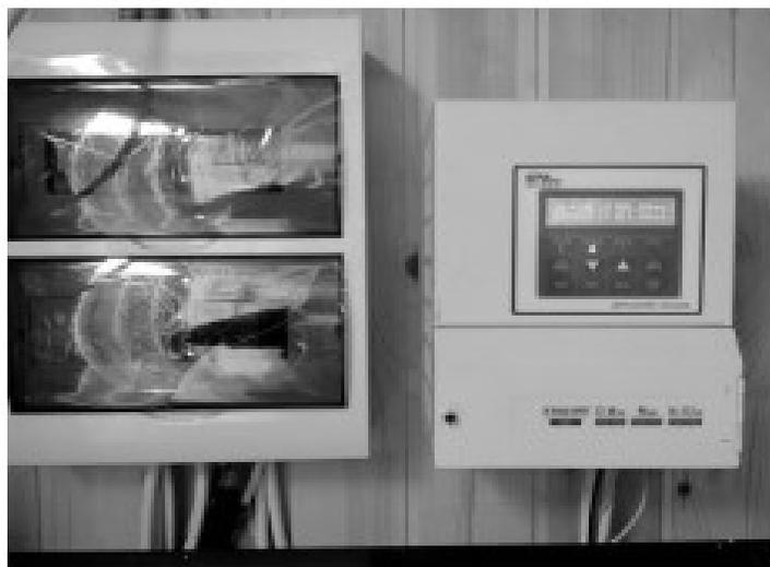
Рис. 36. MPPT контроллер солнечных батарей [9]
