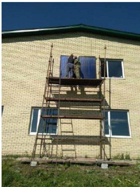
Рис. 17. Установка солнечных коллекторов [27]
