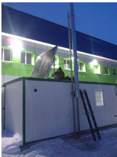
Рис. 25. Установка солнечных панелей [27]
