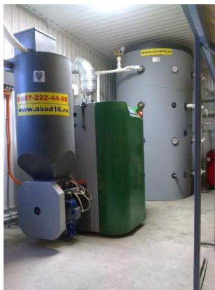
Рис. 26. Котел с автоматической загрузкой и очисткой [27]
