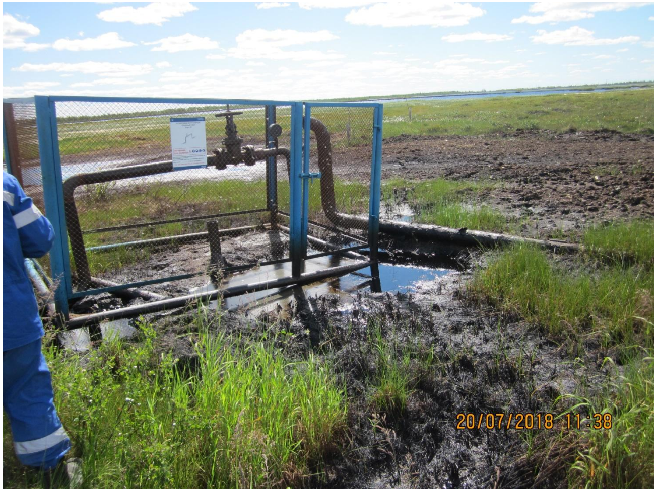
Рис. 7. Место аварийного разлива нефти (Суторминское месторождение, трубопровод нефтесборный, крановый узел)
