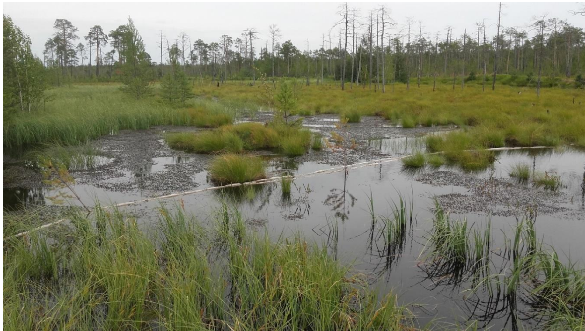
Рис. 3.17. Северо-восточная окраина аварийного участка. Боновые заграждения на расстоянии в 5 м от технологической песчаной насыпи
