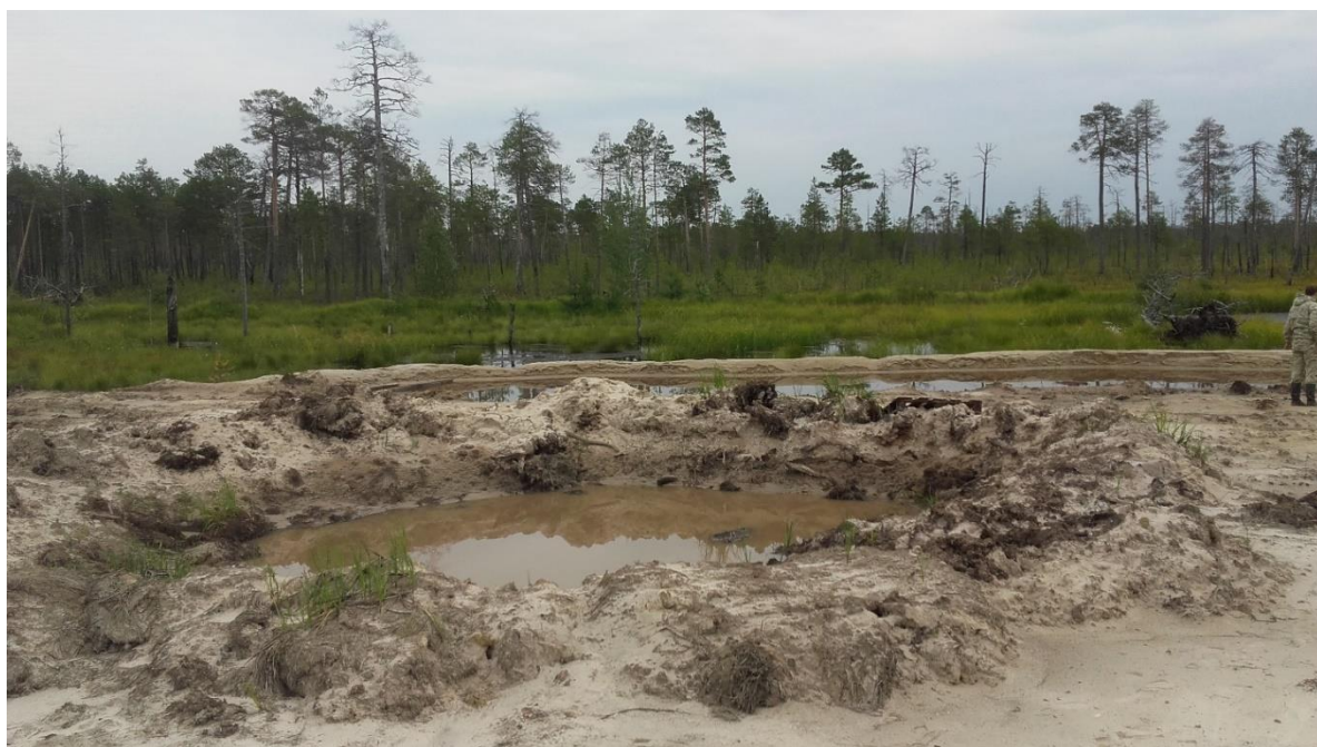
Рис. 3.20. Кратер в средней части технологической грунтовой насыпи на обследуемом участке.
