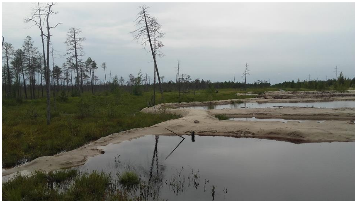
Рис. 3.19. Состояние технологической грунтовой насыпи (август 2019 г.)
